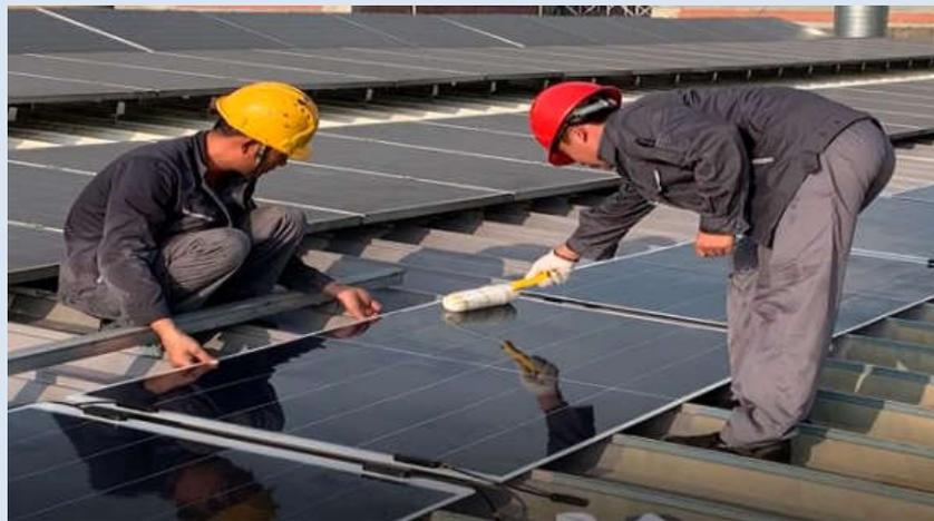
Después de que toda la cinta de espuma de doble cara esté unida al techo, use una rodillo de resina para aplicar una presión uniforme para la fijación. La presión aplicada es la presión de peso muerto del propio rodillo blando.
